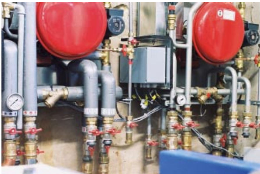
Die Wärmeverteilung, im Bild noch unverkleidet, während der Montage. Wichtige Gruppen der kompakten Wärmeverteilerstationen Q-40 und Q-50 produziert im Auftrag des BHKW-Herstellers Danfoss. Das Verteilungsmodul sichert die hydraulische Funktion und garantiert eine optimale Einbindung des BHKW in die nachgelagerten Heizsysteme
